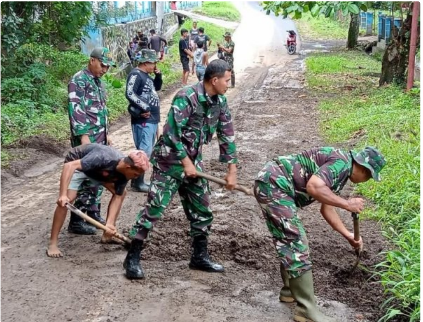
Personil Kodim 1310/Bitung kerja Bhakti bersihkan tanah longsor tutupi akses Jalan
