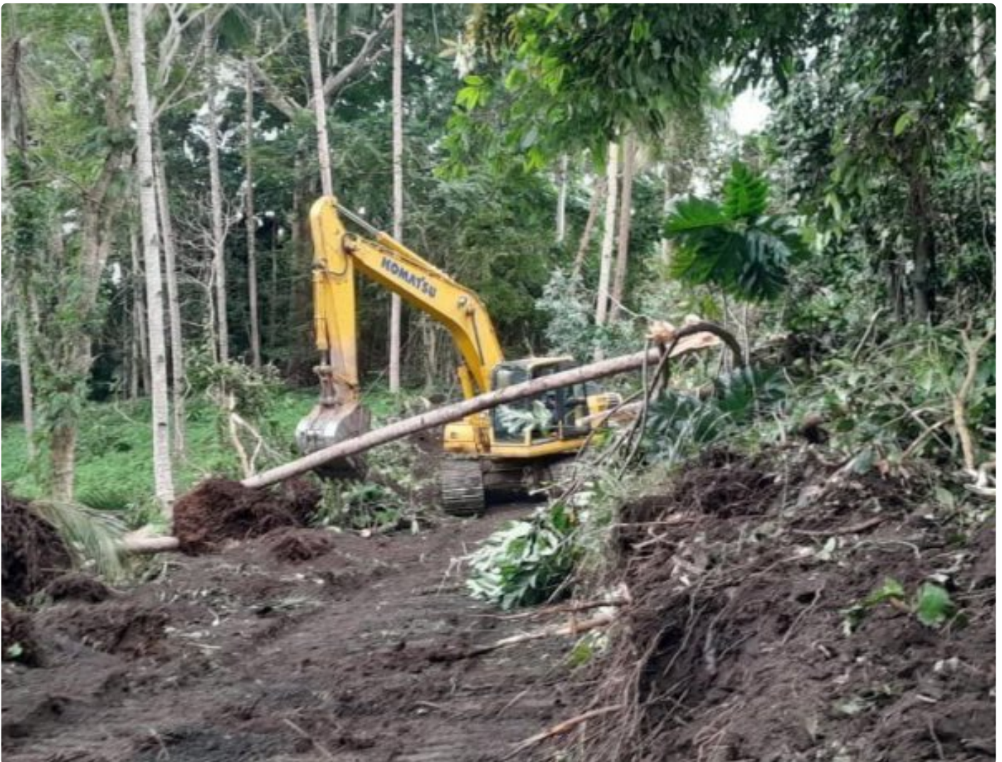
Pekerjaan Infrastruktur Pembukaan Jalan di TMMD Tandurusa
