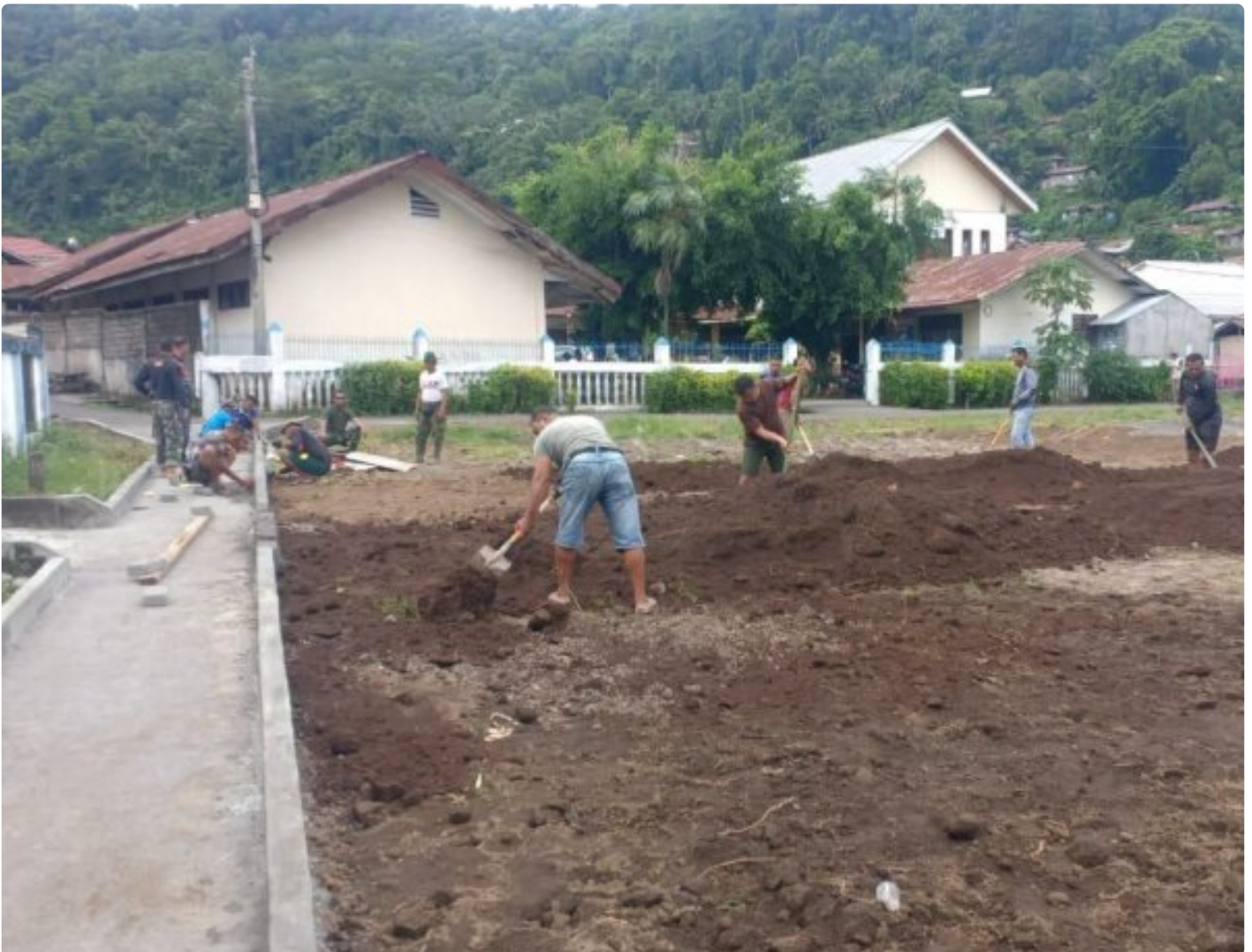
Sarana olah Raga Jogging Track TMMD Ke-116 Kodim 1310 Bitung di Kelurahan Tandurusa
