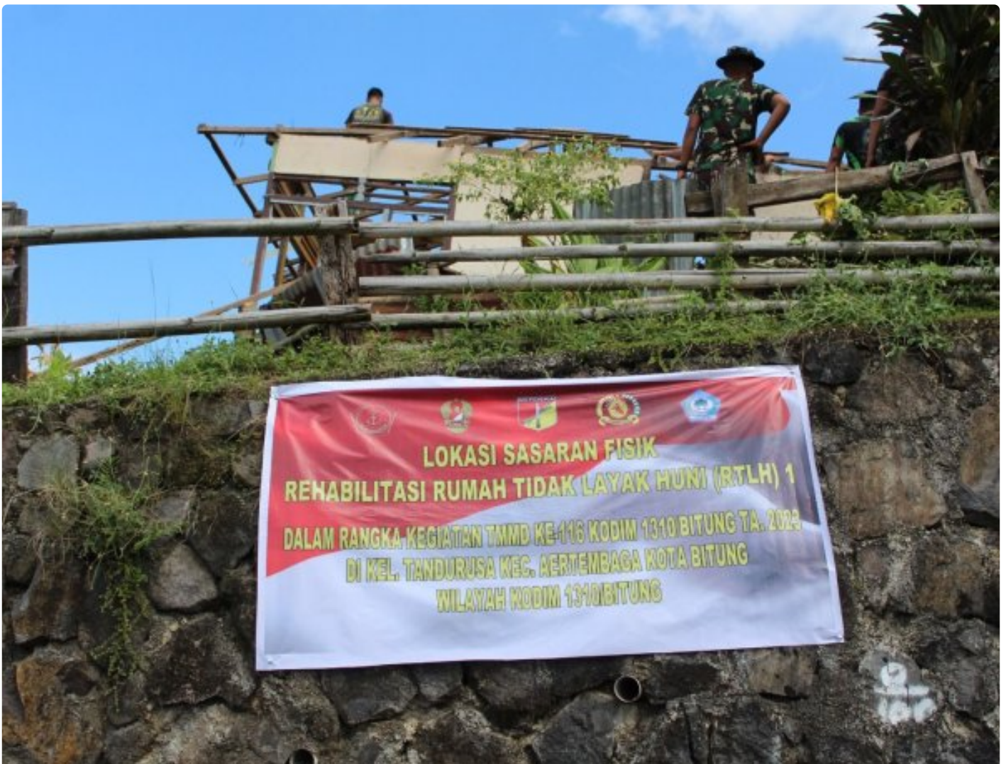
Kegiatan Pembangunan Rumah Tidak Layak Huni (RTLH) oleh Satgas TMMD Ke-116 di Kelurahan Tandurusa
