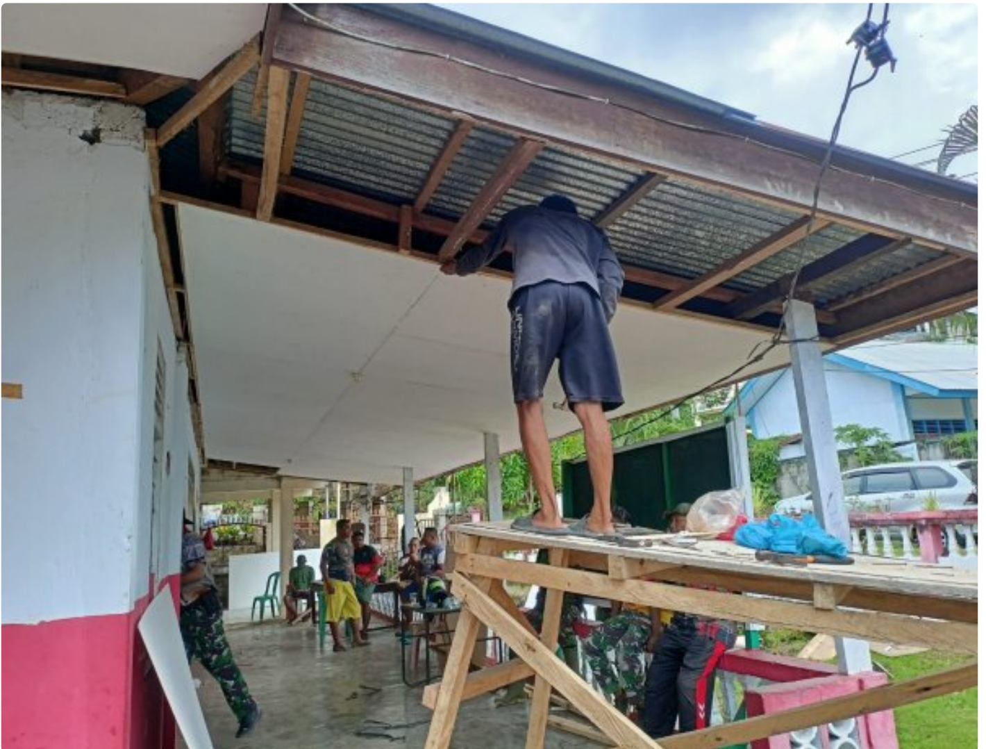
Satgas TMMD Renovasi Kantor Kelurahan Tandurusa
